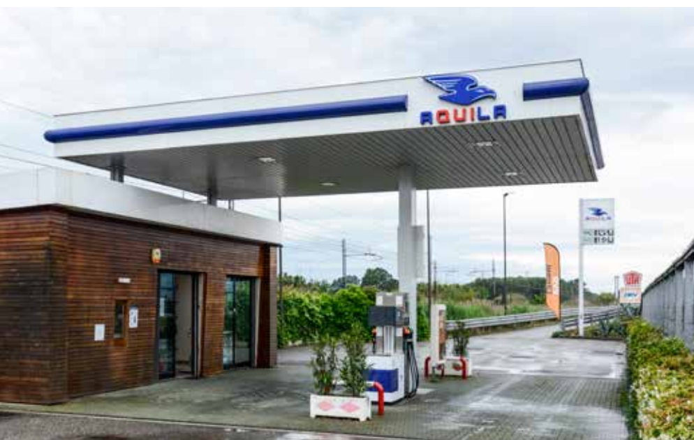
STAZIONE DI VECCHIANO - MIGLIARINO
